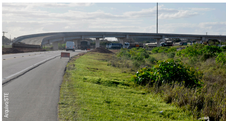
Viaduto da Av. Viscondessa da Graça deve ser o próximo a ser entregue.
